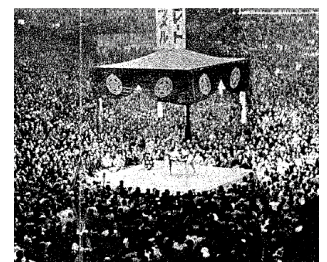
府立体育会館開館当時の吊り屋根 24
